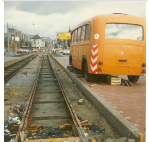
Totalumbau 1980-81 der Linie 2: Ehemaliger Omnibusanhänger umgebaut zum Schweißgerätewagen an der Baustelle Tullastraße. Foto: Stefan Kirner
